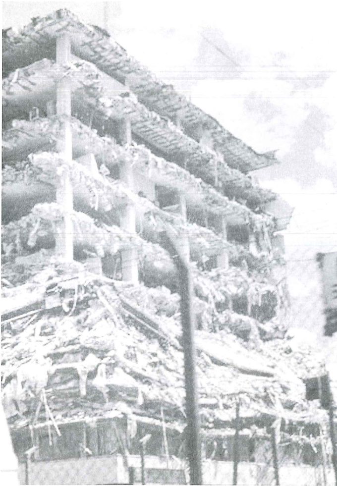
Este edificio ha perdido toda su fachada, quedando como una naranja pelada, quizás alguno de sus armónicos de vibración colabora en el giro sobre sí mismo.
